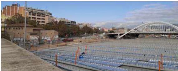
A la imatge superior, la manera com quedarà aquesta 1a fase. Les vies, però, ja estan cobertes, com veïeu a la imatge inferior.
