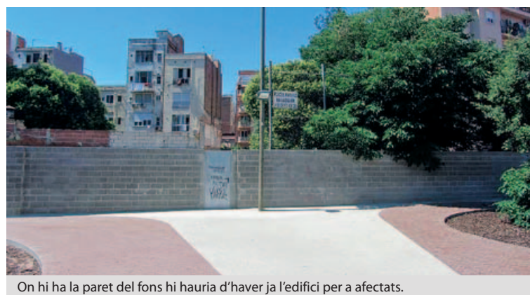
On hi ha la paret del fons hi hauria d'haver ja l'edifici per a afectats.
